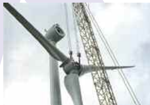
Installation d'une éolienne Falck
