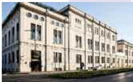
Ancienne centrale électrothermique Falck
