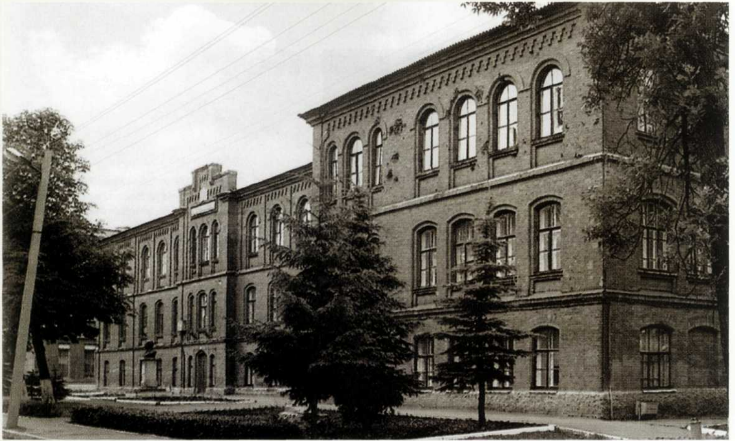
▲ Le bâtiment que Vera Bojanus a fait construire pour l'école normale de Polotsk, en Biélorussie. Il a été inauguré par le grand-duc Constantin, frère du tsar.
